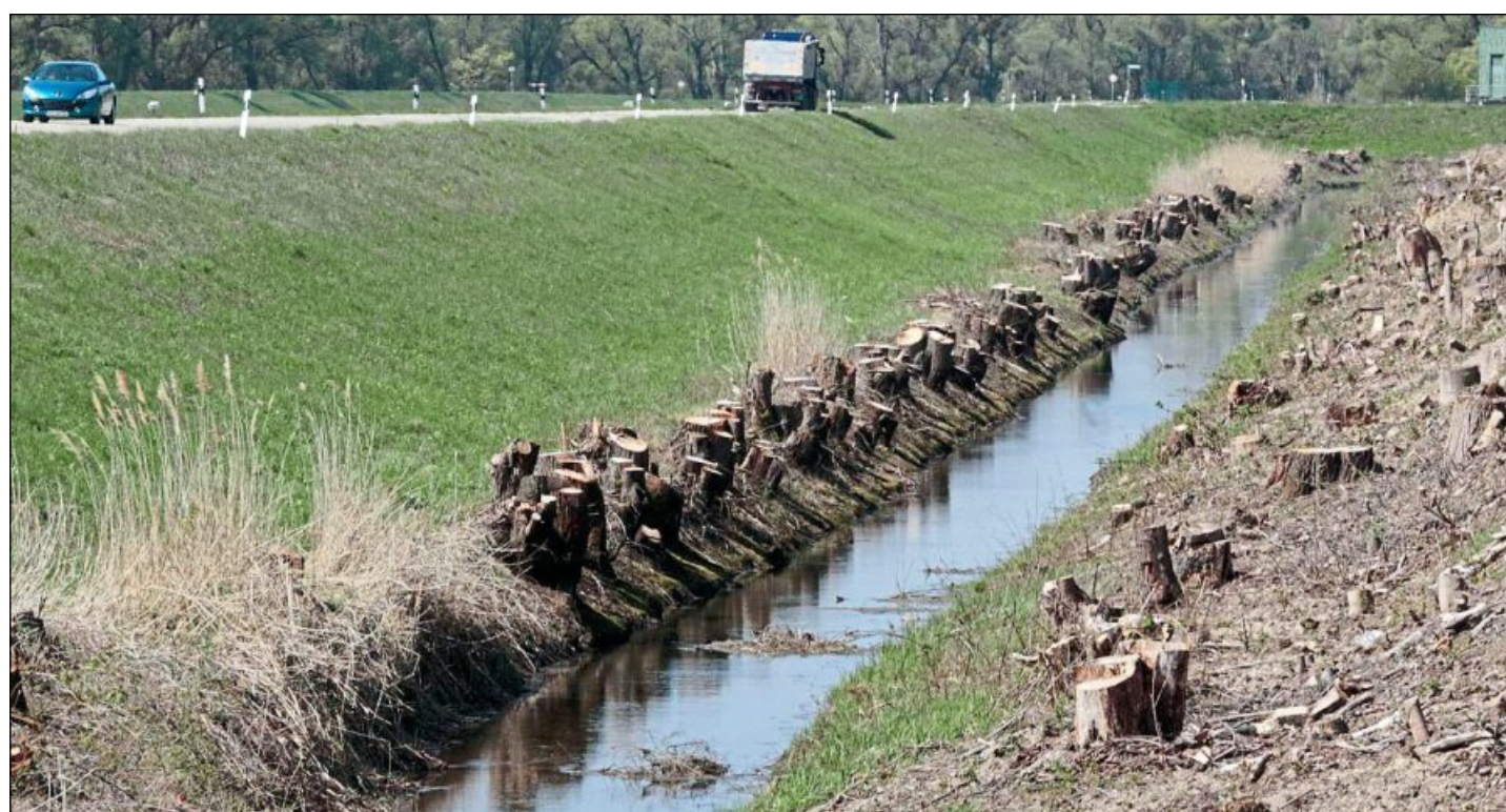
IN BESSEREN ZUSTAND werden die Hochwasserdämme auf Gemarkung Steinmauern versetzt. Die Bauarbeiten wandern und ziehen sich noch bis voraussichtlich Juli 2020. Foto: Vetter
